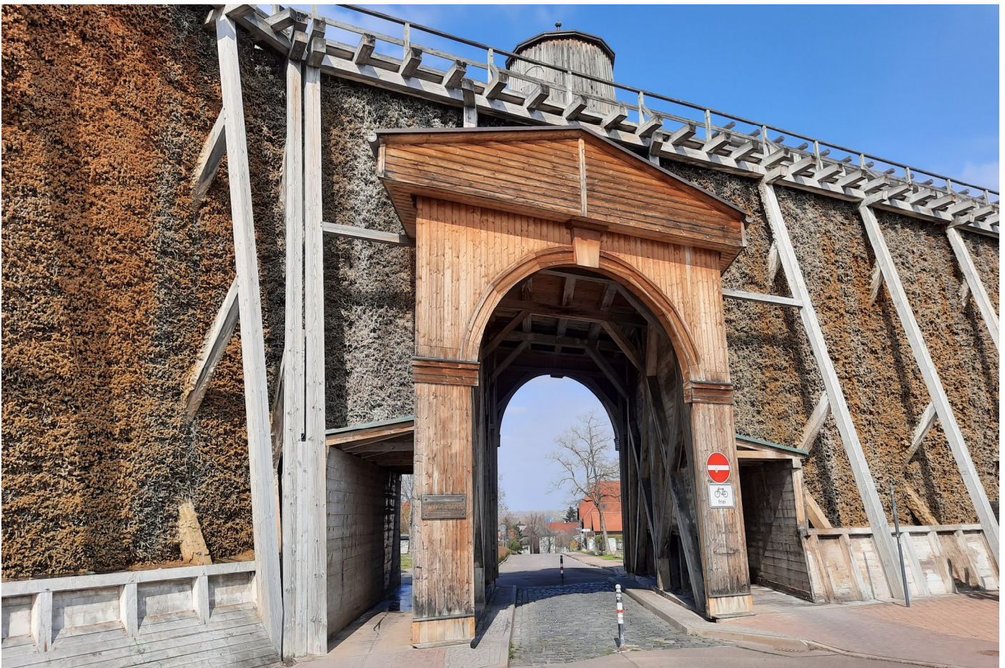
Wegdurchführung durch die Saline in Bad Dürrenberg
